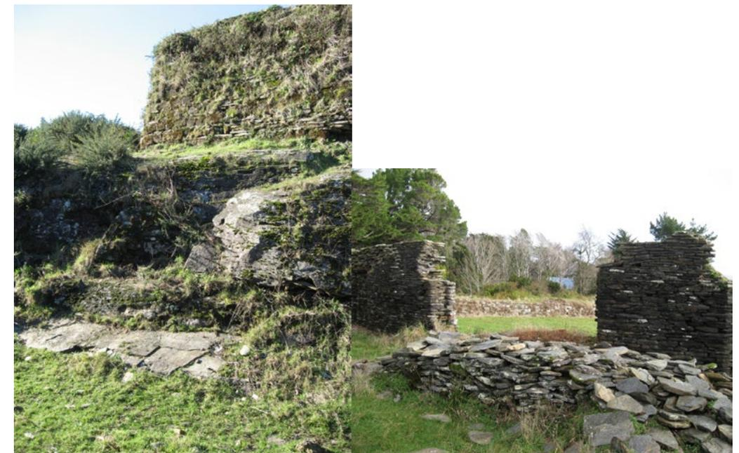
Figuras 6 y 7. Imágenes del Fuerte de Amargos (izquierda) en cuya construcción y posteriores restauraciones se utilizó la canchagua y el esquisto (nótese el afloramiento metamórfico en la base del muro) y el Castillo de Mancera, en cuya construcción y posteriores restauraciones también se utilizó la canchagua y el esquisto.
